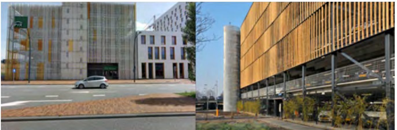
Parkeergarage P&R Beukenhorst en voorbeeldgarage ingepakt in bamboe
